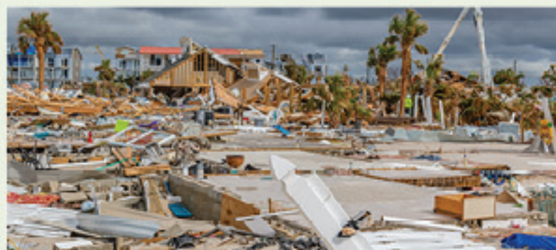
Fig. 9. Distrugerii provocate de uraganul Michael
