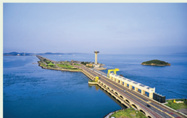
Fig. 8. Barajul centralei mareomotrice de pe Lacul Sihwa (Coreea de Sud)
