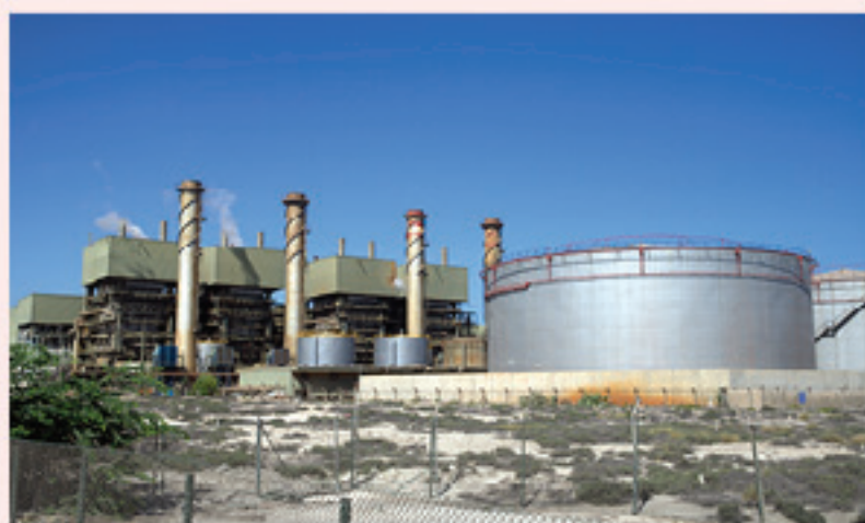
Fig. 3. Centrală de desalinizare a apei, Emiratele Arabe Unite
